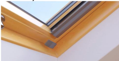
3. založte bočné vodiace profily (postup podľa obr.)
